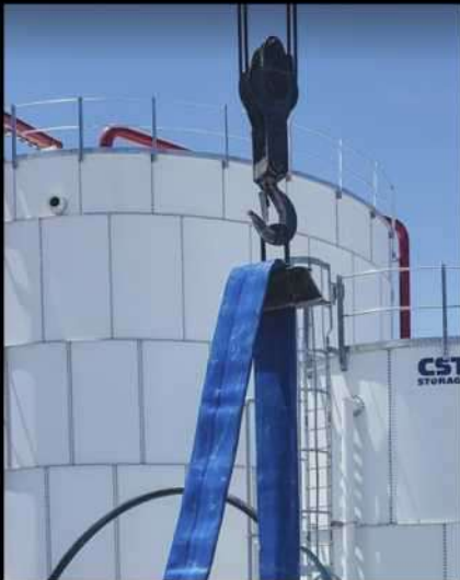
Instalación con grúa y elevadores
